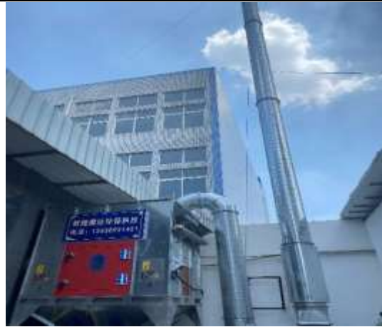
焊烟净化器及排气筒
