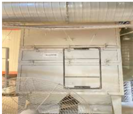
旋风除尘器+转翼式滤芯自洁过滤装置
