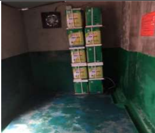
危废暂存间防渗
