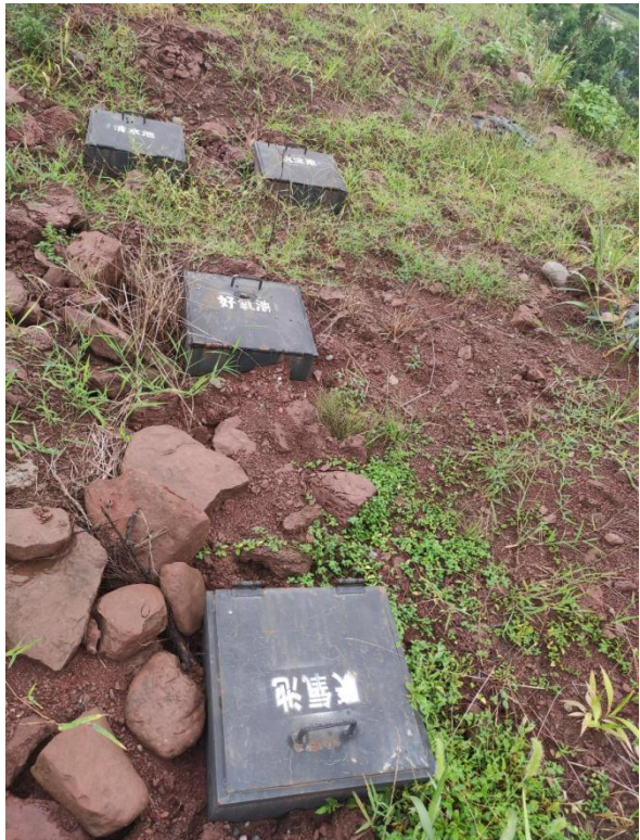
一体化污水处理设施
