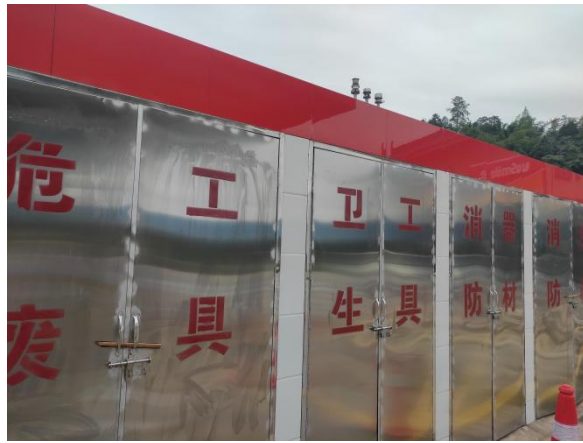
消防沙箱及消防器材（东加油站）
