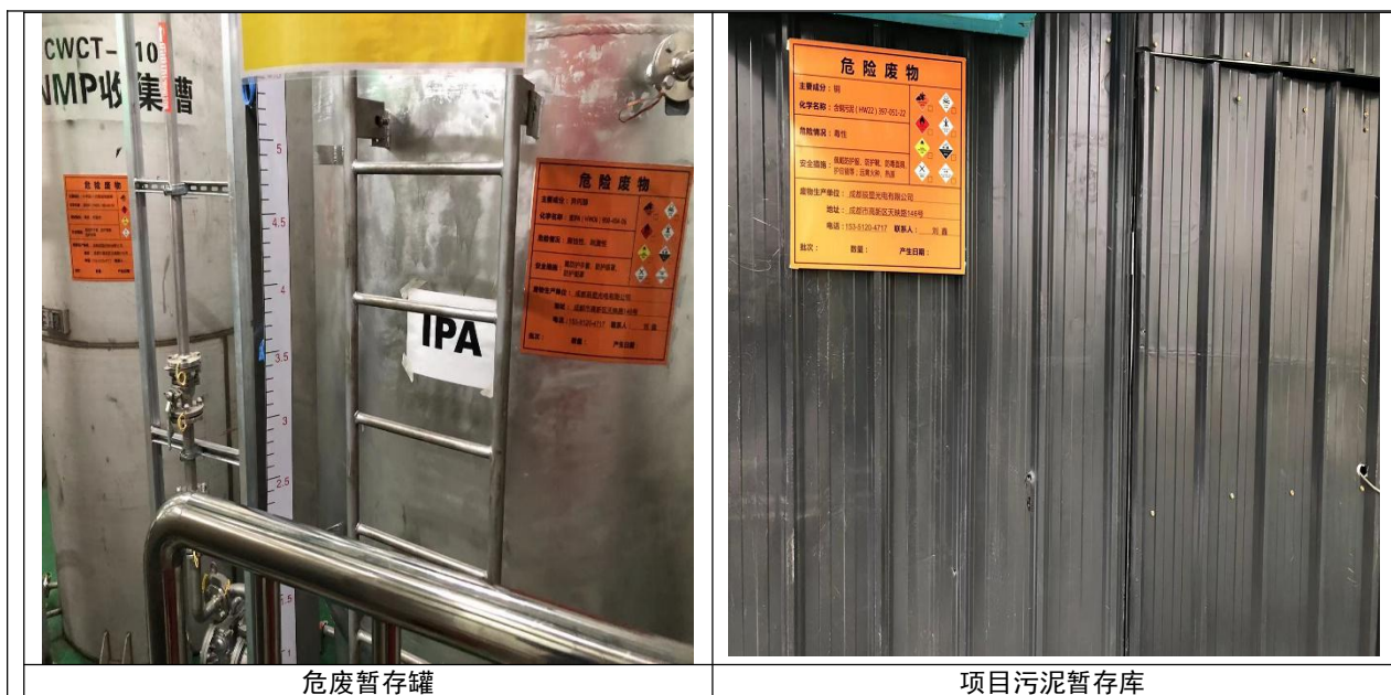
图 3-7 项目危废暂存库
