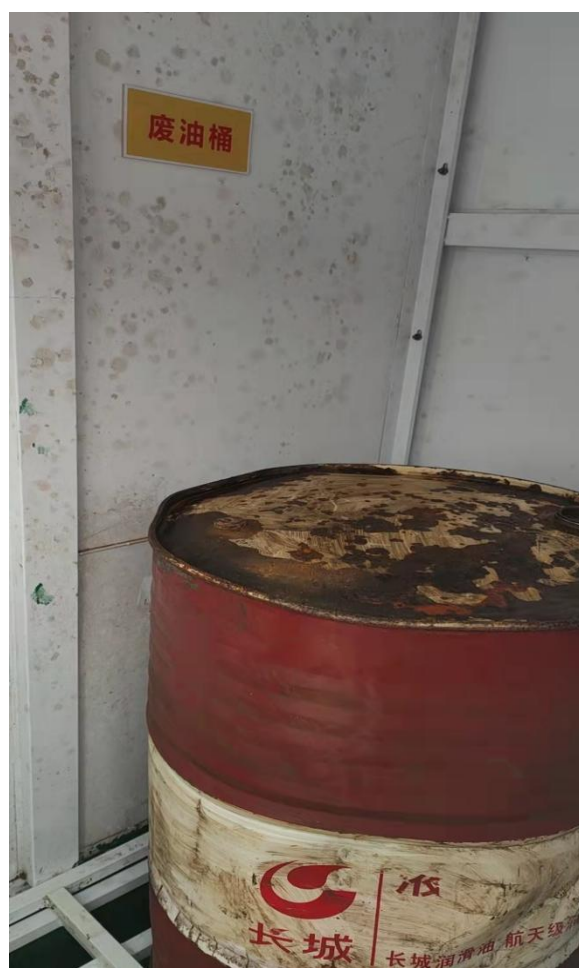
危废暂存间里面的废油桶
