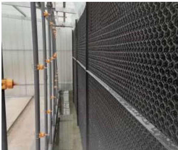
图 4-13 猪舍除臭装置示意图
