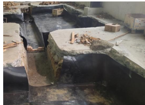
项目防渗施工照片
