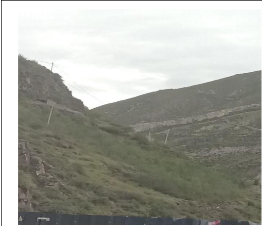
地理式压管道处
