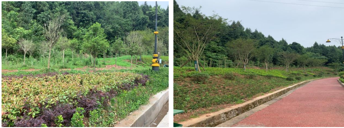
办公区及上坝公路建设临时占地植被恢复情况
