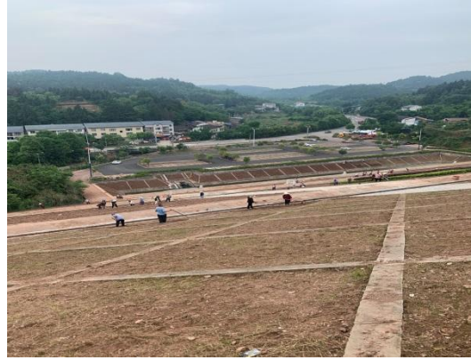
水库坝区植草人工翻种
