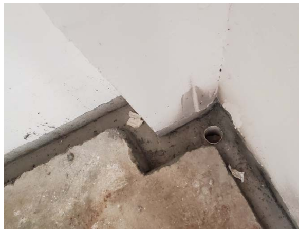
垃圾压缩站导流沟
