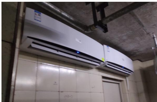
垃圾房降温措施
