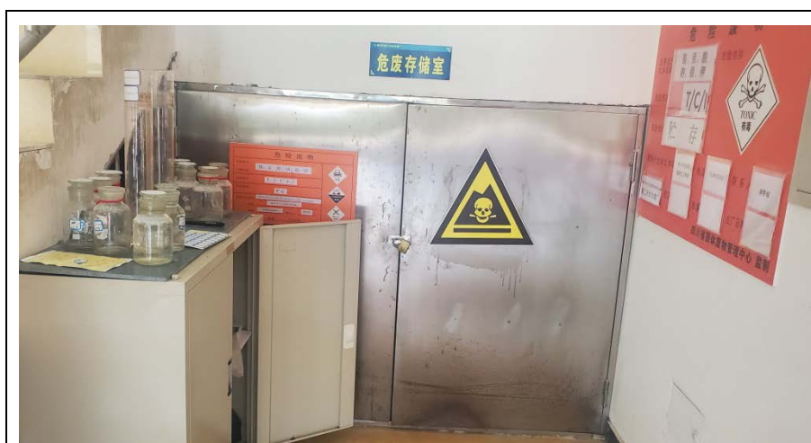
危废暂存间现状
