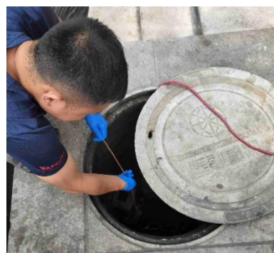
汇融国际废水总排口
