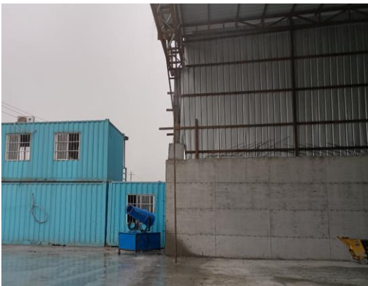
2#厂区 成品料场出口处 雾炮器
