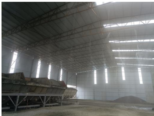
搅拌楼配套的计量斗位于车间内，设置喷雾降尘
