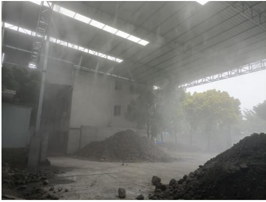
1#厂区原料堆场及喷雾降尘
