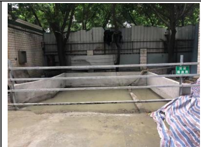
1#厂区入口隔油沉淀池
