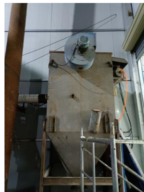
2#厂房盾构料分离生产线粉尘收集设施、除尘器及喷雾降尘系统
