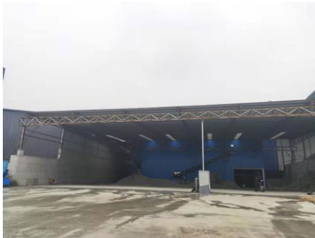
2#厂房皮带输送封闭+喷雾降尘
