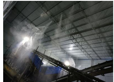
2#厂房盾构料分离生产线粉尘收集设施、除尘器及喷雾降尘系统
