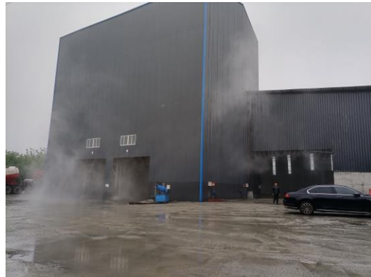
搅拌楼厂房及喷淋系统
