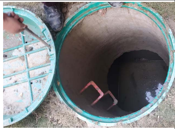
污水预处理池
