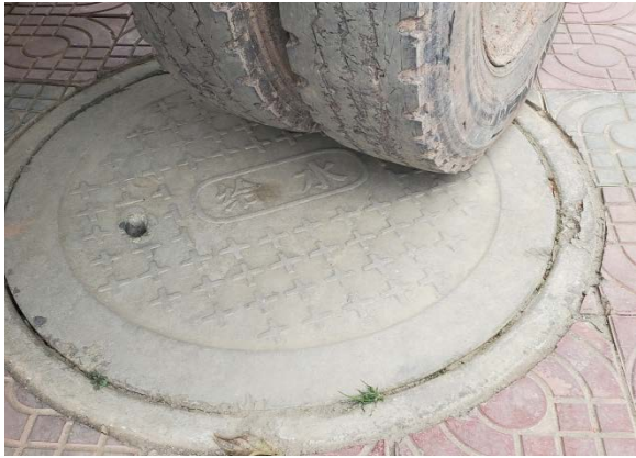
桃园路引水管道
