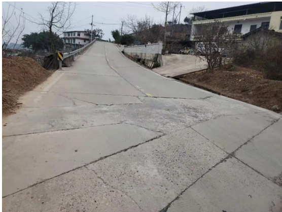
管道穿越道路恢复情况
