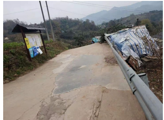
管道穿越道路恢复情况
