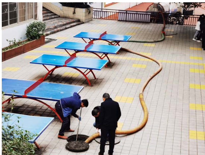
预处理池污泥清掏图片
