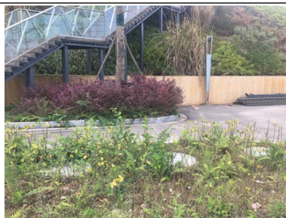
北侧停车场预处理池
