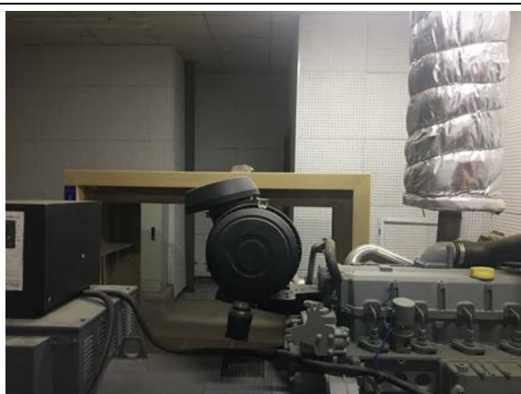
发电机房隔音墙体
